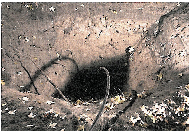
2. Station: Baustelle im Garten. Ein Bohrloch von dreieinhalb Metern Tiefe erschließt das Grundwasser.
