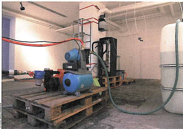
3. Station: Maschinenraum in der Studiogalerie. Hier wird das Grundwasser aus dem Garten zu Trinkwasser aufbereitet.
